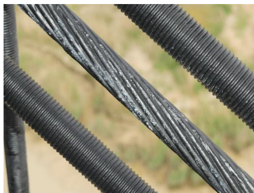
Figure 5 : Traces blanchâtres sur hauban
